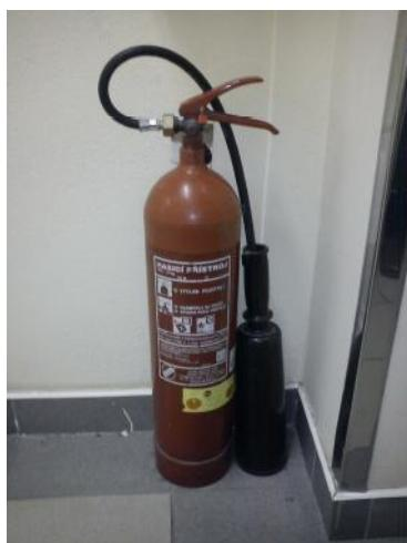
4.6.2 Práškové hasicí přístroje - jedná se o přístroje plněné univerzálním hasivem s velkým hasebním účinkem. Lze s ním hasit všechny kategorie požáru (A až C, vč. el.zařízení pod napětím do 1000 V). Princip hašení – chemické, hasivo vstupuje do chemické reakce hoření.
